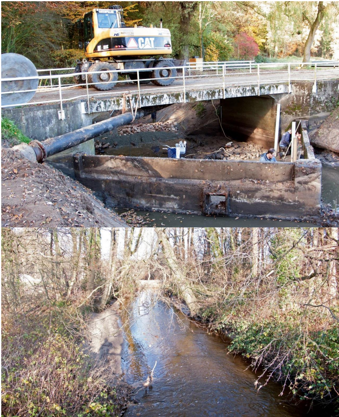
Figuur 3.8. Dam removal van de Slinge, voor en na de maatregel (respectievelijk boven en onder). Foto's Matthijs de Vos.
