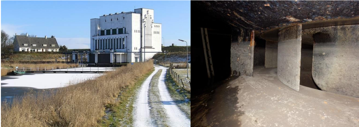
Figuur 3.4 Vooraanzicht van gemaal Lely te Medemblik (foto Rik Beentjes, HHNK) en van de waaier in de pompkelder (foto Leo Broers, HHNK).
